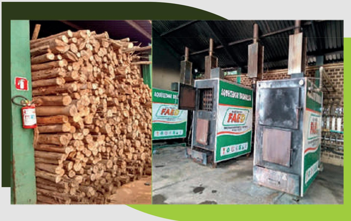
O aquecedor de biomassa é utilizado para o aquecimento da água, sendo uma ótima opção sustentável por não utilizar fontes não renováveis de energia. No Parque, optamos por utilizar eucalipto certificado, opção economicamente viável especialmente no inverno pelas baixas temperaturas, além de fácil manejo e armazenamento.
